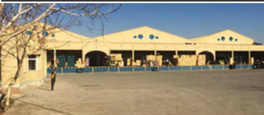
سردخانه نجف آباد (نجف آباد - اصفهان) - عیب یابی کمپرسور آمونیاک سابرو
